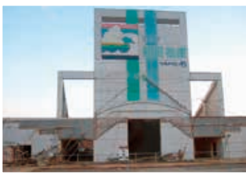
旧道の駅陸前高田。松の倒木が未だ中に入ったままです。
